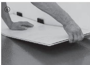
Следующие элементы первого ряда защелкиваются сверху на торцах в предыдущую доску. После быстрого нажатия на поперечный стык элемент входит в зацепление со смежным элементом. При этом необходимо обращать внимание на точную соосность элементов. Последний элемент первого ряда должен быть отрезан так, чтобы между ним и стеной оставался расширительный шов 10-15 мм, и вставлен в смежный элемент.
