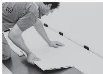
Оставшаяся часть первого ряда служит началом следующего ряда (смещение с торцевой стороны не менее 18 см). Благодаря этому существенно уменьшается количество отходов. Далее выполняется укладка отдельных элементов. Для этого элементы сначала вставляются продольной стороной с помощью легкого нажатия с поворотом в смежную доску.
