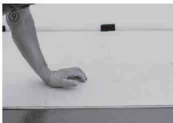
Затем элемент опускается с торцевой стороны. При этом следите за тем, чтобы элемент с торцевой стороны соединялся встык с предварительно уложенным элементом и находился на одном уровне с ним. После быстрого нажатия на поперечный стык элемент фиксируется.
