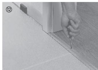
Для обеспечения компенсационного зазора в дверных проходах необходимо всегда применять соответствующую систему профилей. Это следует делать также и тогда, когда в прилегающем помещении укладывается такой же пол. В шине необходимо соблюдать компенсационный зазор мин. 5 мм. Деревянные дверные рамы должны всегда обрезаться на толщину паркетного элемента пилой для чистовой распиловки, чтобы Celenio имел возможность расширения.
