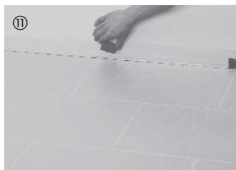
После укладки необходимо в обязательном порядке удалить распорные клинья. Прикрепите плинтусы к стене (с зажимами или без них) – и все готово. Указание: Для выступающих из пола труб отопления в элементах пола высверливаются соответствующие отверстия с соблюдением нужного компенсационного зазора.
