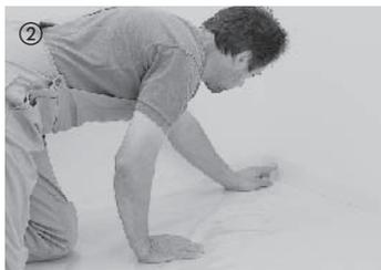
В случае безшовных стяжек и при укладке на обогреваемый пол следует всегда подкладывать полиэтиленовую пленку толщиной 0,2 мм. В зоне стыков внахлест пленки должен составлять 30 см. Уложенную пленку следует подтянуть вверх возле стены и после монтажа плинтуса отрезать выступающий край.
