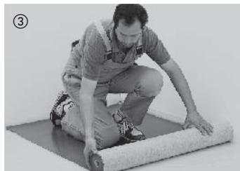
Для изоляции от ударного шума и для сглаживания небольших неровностей укладывается заподлицо изоляционная подкладка Komfort толщиной 2 мм. Подходящие изоляционные подкладки представлены в нашем ассортименте вспомогательных материалов. Битумный картон непригоден для изоляции ударного шума. **Для CELENIO Silent Pro® не разрешается применять дополнительную изоляционную подкладку.**
