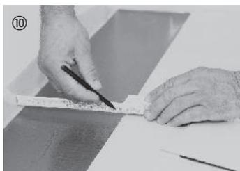
Элементы последнего ряда обрезаются с продольной стороны с учетом компенсационного зазора 10-15 мм и подгоняются.
